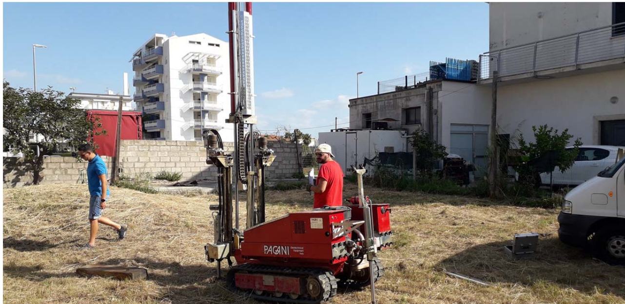
Figura 2 - Ubicazione della prova penetrometrica dinamica super pesante P1
